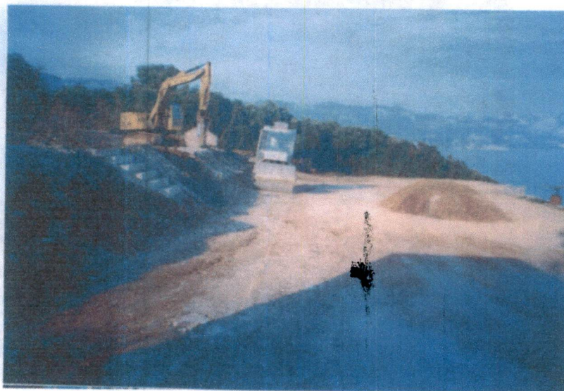
Sl. 14. Nabijanje i valjanje tampona
