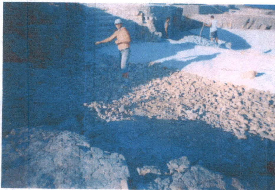
Sl. 11. Ručno razastiranje i ravnanje drobljenog kamena i tampona
