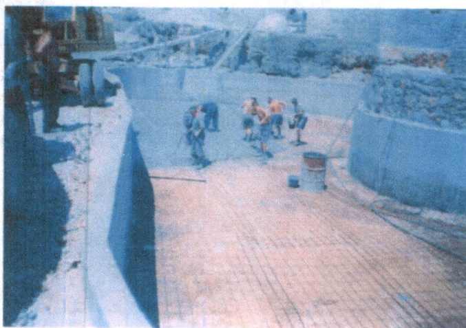
Sl. 7. Betoniranje dna bazena
