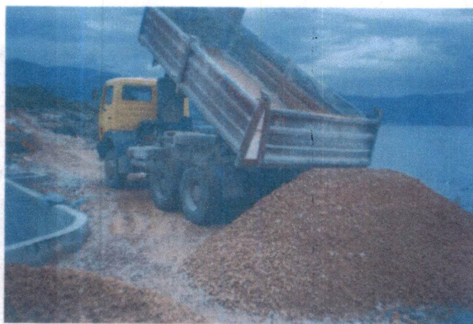
Sl. 12. Dovož tampona
