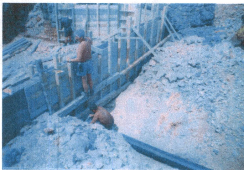
Sl. 6. Betoniranje košuljice bazena
